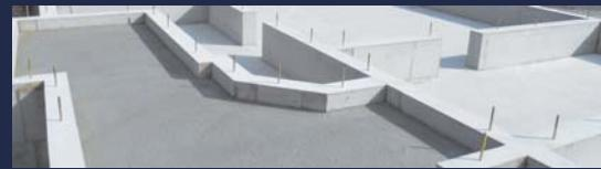
建物全体の重量を支え、地震などの外力を地盤に分散させる基礎。強度と耐久性に優れた鉄筋コンクリート造の「ベタ基礎」を採用しています。
